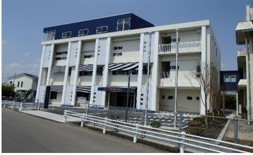
① 消防本部(災害支援拠点施設)
